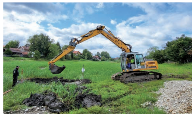
2023 wurde der völlig verlandete Weiher komplett ausgebaggert, erhielt einen neuen „Mönch“ zur Wasserstandsregulierung, wurde neu befüllt ...
