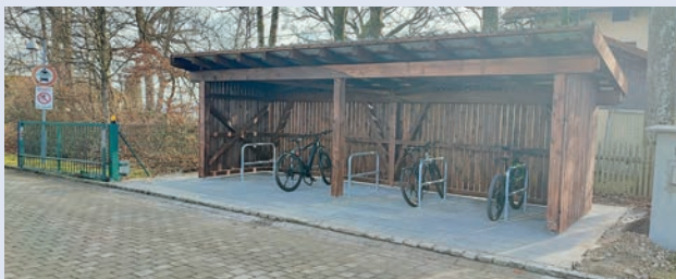
Umweltfreundlich in Bauweise und Nutzung: der neue Fahrradunterstand.
