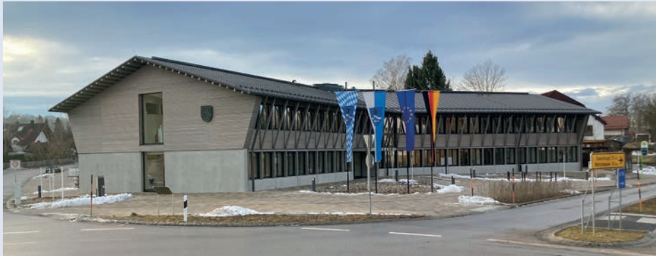
Umweltschonende Versiegelung: Im Außenbereich des Rathauses sind Klimasteine verlegt.
