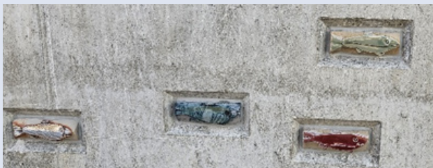
Die aus hochwertiger Keramik gefertigten Fische und Motive wurden in die Maueraussparungen eingesetzt.
