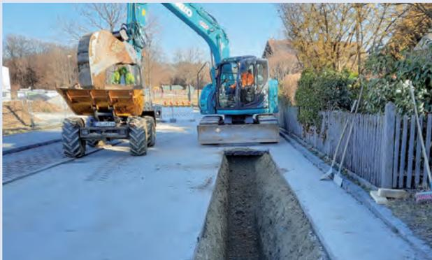
Firma Holzer in Aktion: die Fertigstellung der neuen Trinkwasserleitung.
