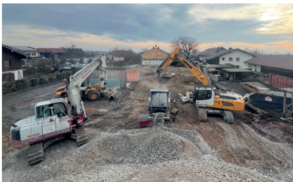
Rückbau und Recycling nach Großbrand in Münsing
