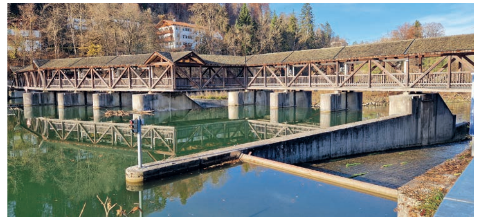
Beeindruckende Anlage mit überdachtem hölzernen Steg; das Kastenmühlwehr, rechts die Floßbrutsche.
