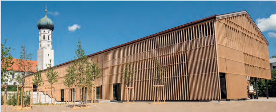
Das neue Münsinger Bürgerhaus, das die Gemeindeverwaltung und einen neuen Veranstaltungssaal umfasst.
