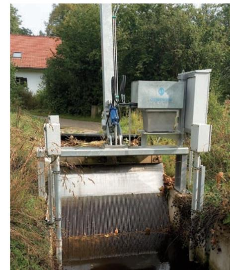
Ausbau am Lüßbach: links eine Fischwanderhilfe (während der Vegetationsperiode nicht zugänglich), rechts eine automatisierte Rechenreinigungsanlage.
